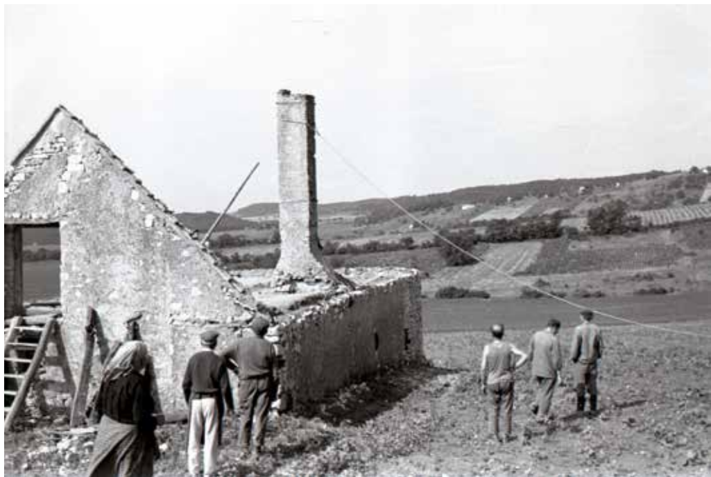
2. kép. Malombontás. A kémény lehúzása
