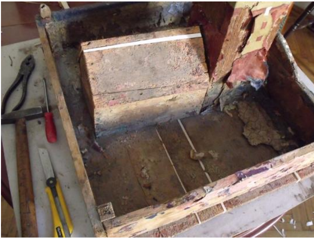
A törött, szétszáradt templomtető és a talpdeszka réseinek bepótlása balsafával.
