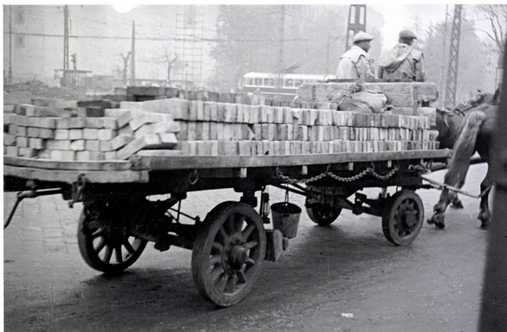
9. kép. Téglával megrakott hátsó fékes laposkocsi hajtóval és kocskísérővel, a kocsi alá akasztott húzatólánccal
